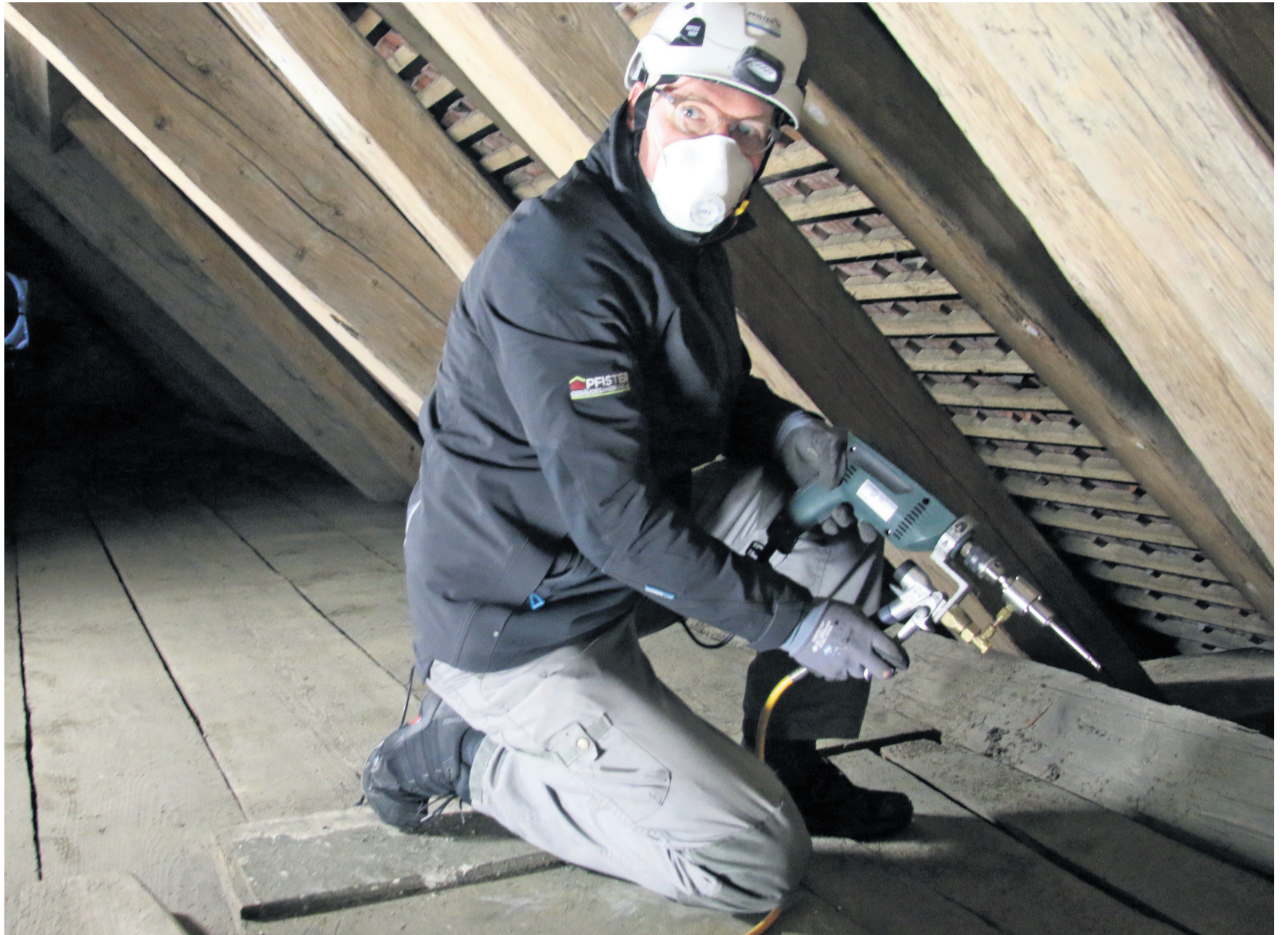
Statt oben im Turm demonstriert Fabian Pfister sein Gerät auf sicherem Terrain: Mit dem Hohlbohrer erschliesst er sich die Frassgänge des Hausbocks. Durch das Loch kann er anschliessend im gleichen Arbeitsschritt das Insektizid spritzen. Fotos Stefan Bossart
